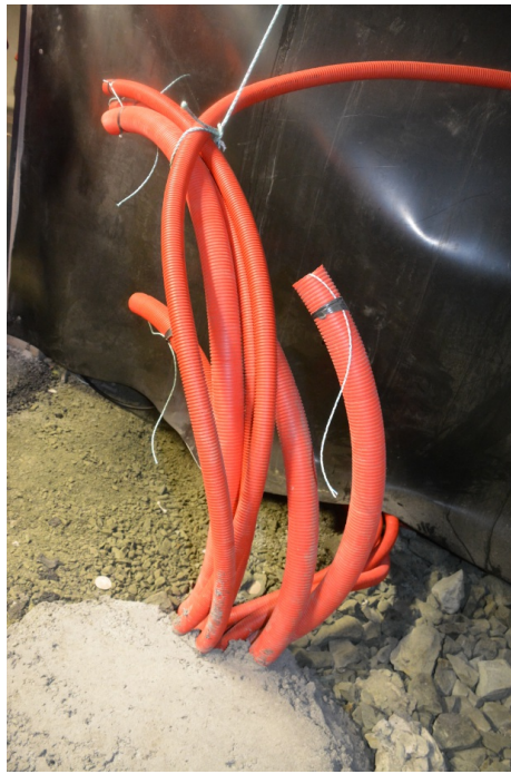
Trekkerør i bankett. Foto: Tore Paulsen
