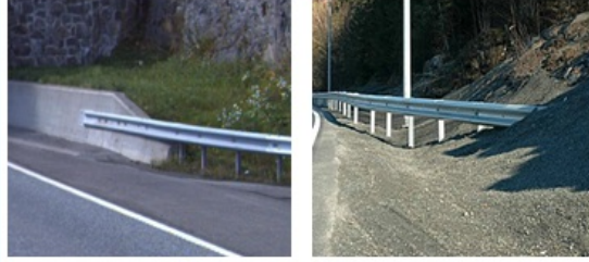
Sideforankring i mur og jordskjæring
