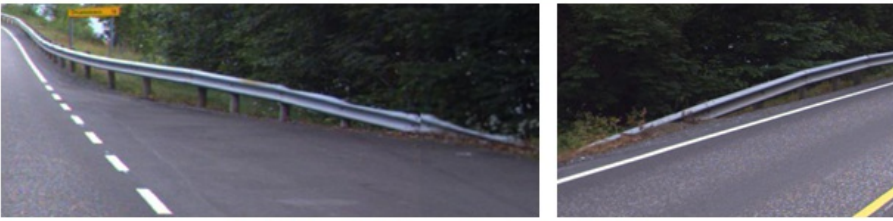
Nedføring i bakken med og uten utsvinging
