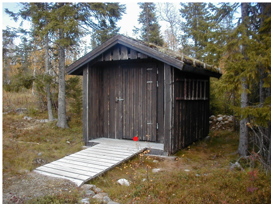
Figur 4: Eksempel på et enkelt eldre toalettanlegg med et toalett. Punkt for registrering av geometri markert med rød prikk(midt på dør)
