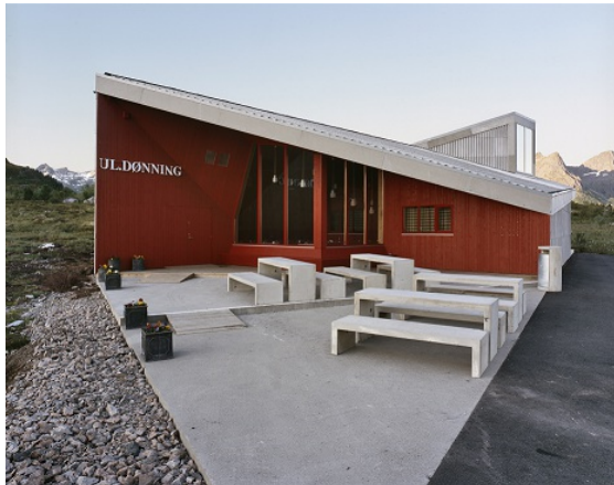
Figur 3: Eksempel på toalettanlegg i privat bygg
