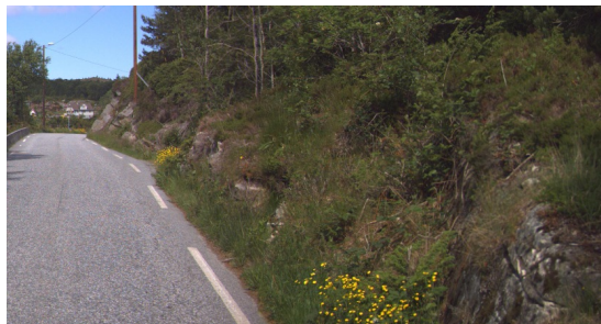
Foo: Statens vegvesen
