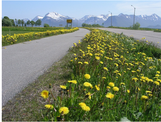
Vegstrekning med trafikkdeler mellom veg og GS-veg. Foto: Statens vegvesen
