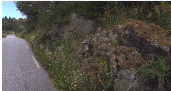
Fto Statens vegvesen
