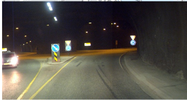
Rundkjøring i tunnel
