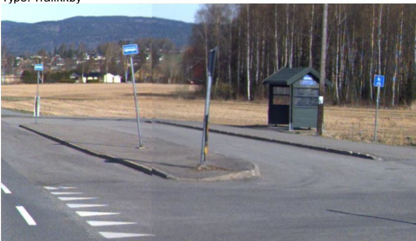
Figur 4: Eksempel på repos/venteareal på ensidig busslomme
