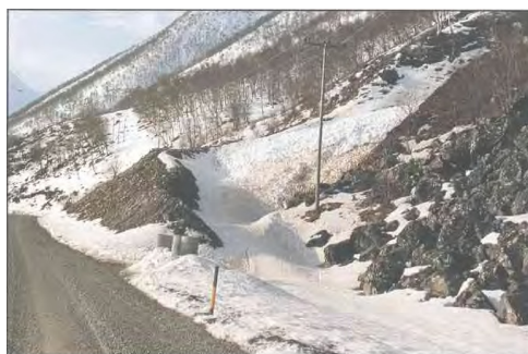
Figur 2.15 Ledevoller kan brukes som separate sikringstiltak ved å endre skredets retning parallelt med veien. (Foto: A. Hustad).
