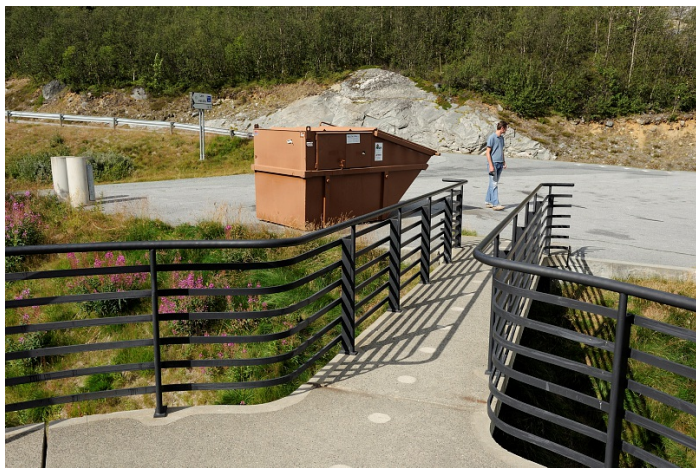
Avfallscontainer på rasteplass. Foto: Jarle Wæhler
