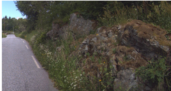
Fto Statens vegvesen
