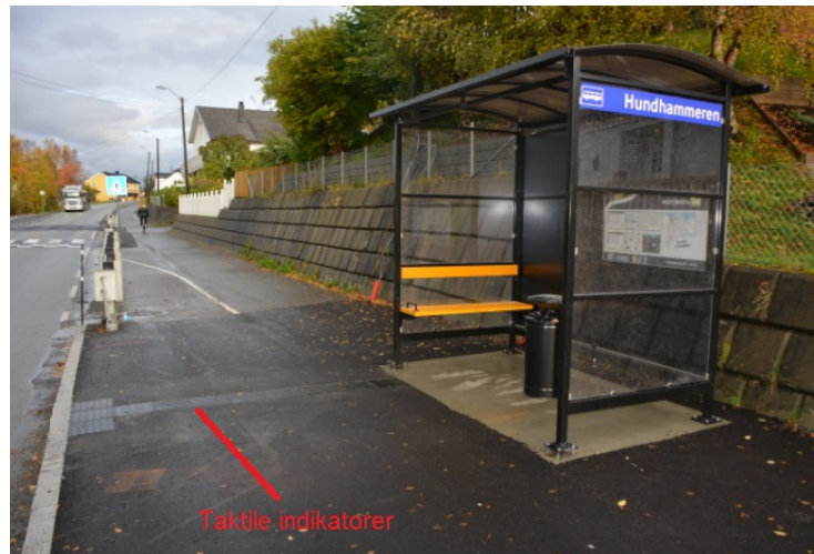
Taktile indikatorer ved busstopp. Foto: Tore Paulsen
