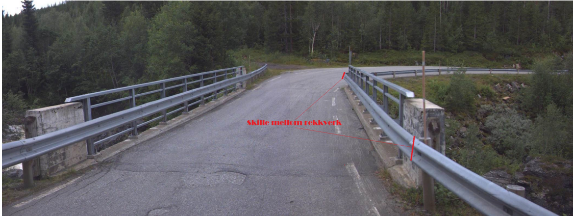
Rekkverk på/ved bru. Foto: Statens vegvesen
