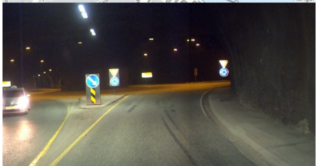
Rundkjøring i tunnel
