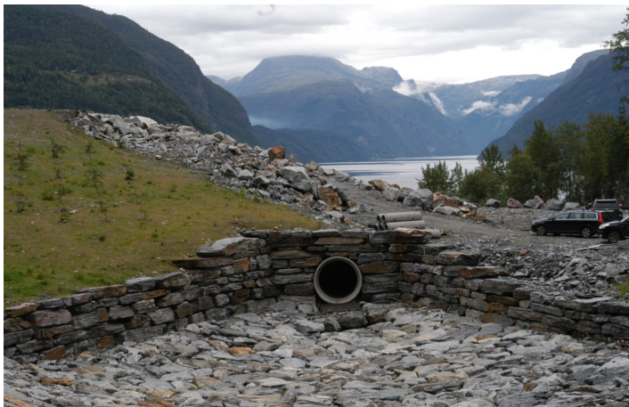
Figur 3: Skredmagasin. Foto: Geir Brække
