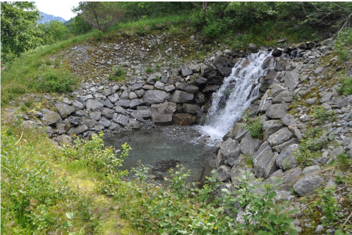
Figur 7: Sikring for sørpeskred/flomskred. Foto: Marie Drågen
