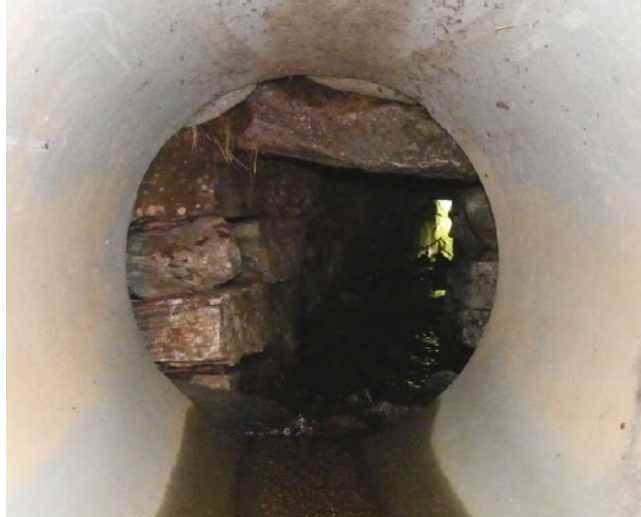
Stikkrenne som må deles i to objekter i NVDB
