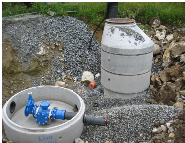
Vannkummer. Foto Terje Rønneberg
