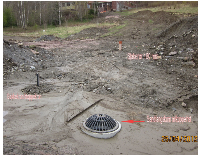
Sandfangskum, bakkekran og stakerør. Foto Terje Rønneberg
