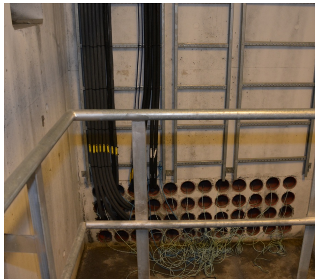
Trekkerør inn til hovedfordeling. Foto: Tore Paulsen
