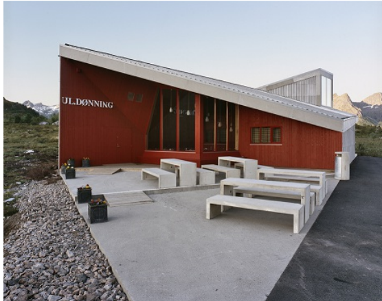
Figur 3: Eksempel på toalettanlegg i privat bygg
