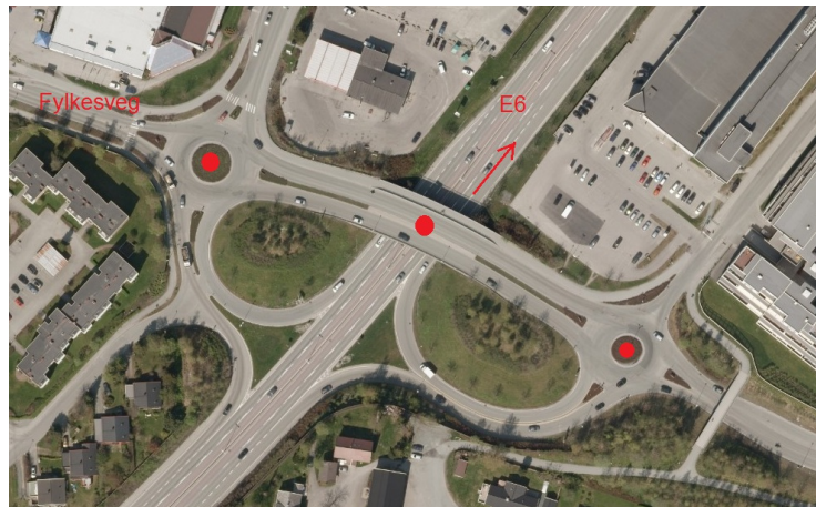
Moholtkrysset på Omkjøringsvegen i Trondheim
