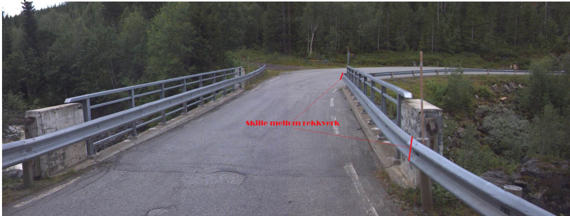
Rekkverk på/ved bru. Foto: Statens vegvesen
