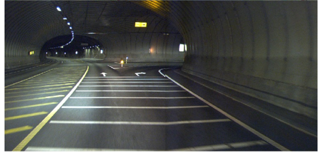
T-kryss i tunnel
