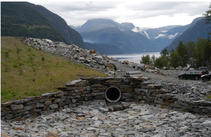
Figur 3: Skredmagasin. Foto: Geir Brække
