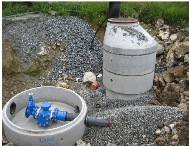
Vannkummer. Foto Terje Rønneberg
