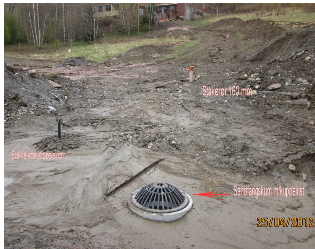
Sandfangskum, bakkekran og stakerør. Foto Terje Rønneberg
