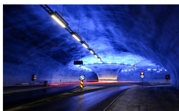
Lyssetting i Vallaviktunnelen. Foto Knut Opeide
