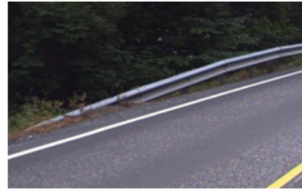
Nedføring i bakken med og uten utsvinging
