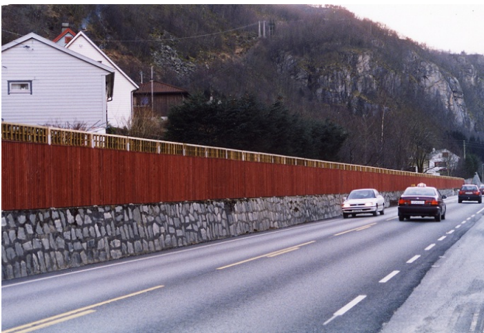
Figur 7: Skjerm med bruksområde støyskjerm
