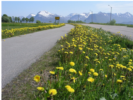
Vegstrekning med trafikkdelers mellom veg og GS-veg. Foto: Statens vegvesen
