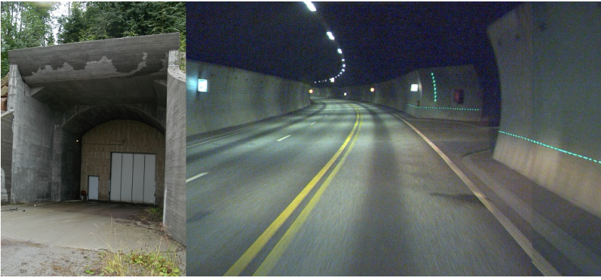
Tverrslag på utsida og i tunnel
