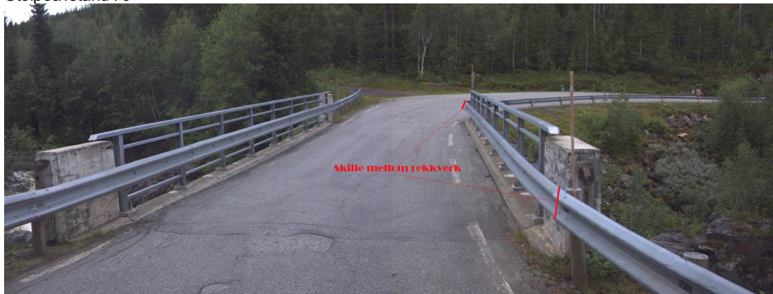
Rekkverk på/ved bru. Foto: Statens vegvesen
