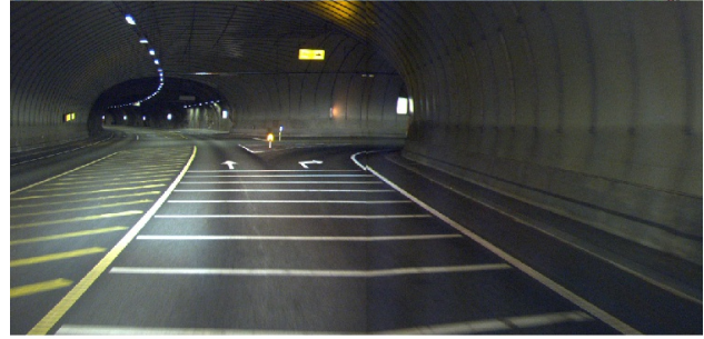
T-kryss i tunnel
