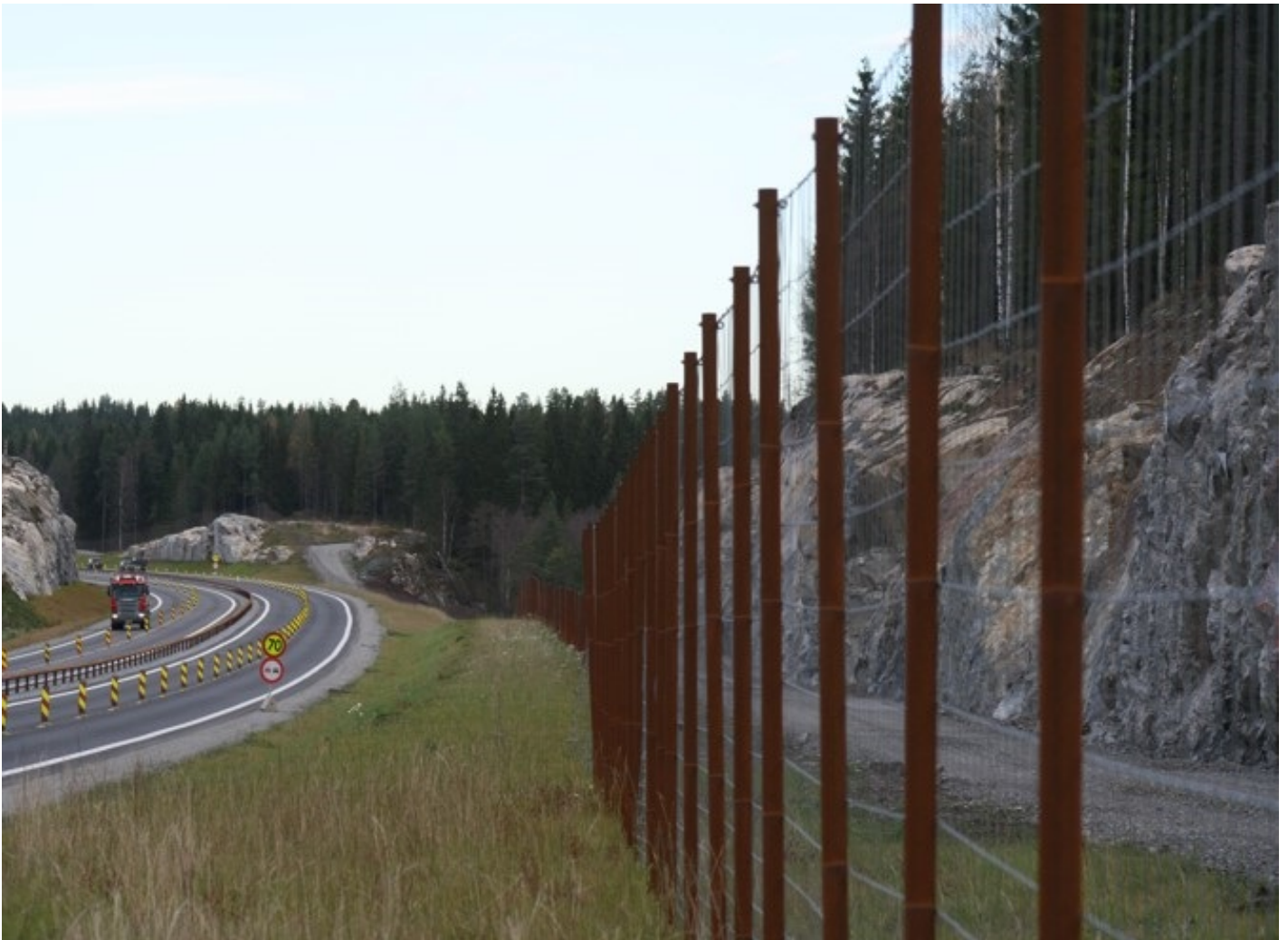
Viltgjerde anbefales bruk når ÅDT er mer enn 10 000. Rv3, Gardermoen (Foto: B. Iuell, Håndbok V134) se også håndbok N200 for teknisk beskrivelse. (Foto: Karianne Thøger-Andresen).
