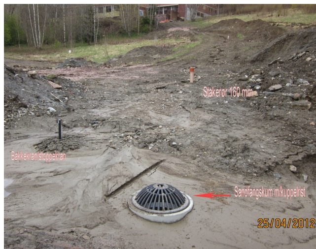
Sandfangskum, bakkekran og stakerør. Foto Terje Rønneberg
