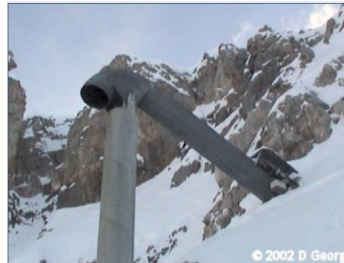
Figur 4: Skredutløsning med GazEx
