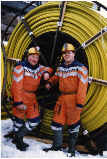
Figur 3: Trekkerør på trommel. Foto Charlotte V. Nielsen
