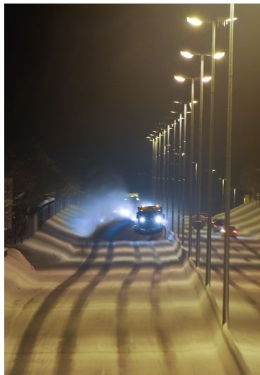
Lyssetting langs midtdeler på omkjøringsveien i Trondheim. Foto Knut Opeide
