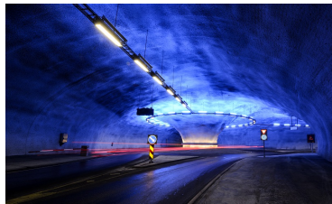
Lyssetting i Vallaviktunnelen. Foto Knut Opeide
