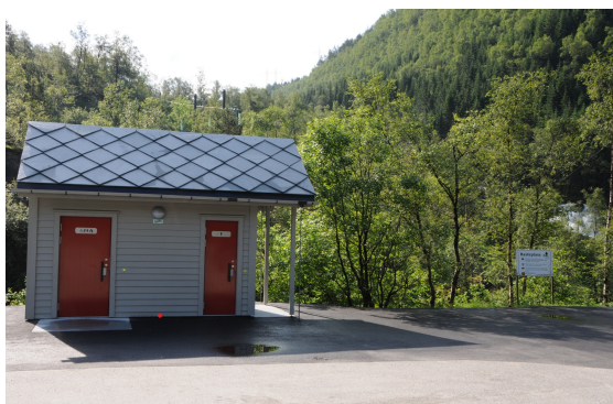
Figur 4: Eksempel på et toalettanlegg med to toaletter. Punkt for registrering av geometri markert med rød prikk (midt på dør)
