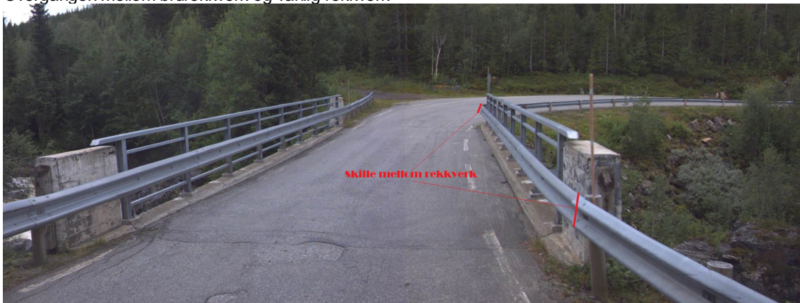
Rekkverk på/ved bru. Foto: Statens vegvesen
