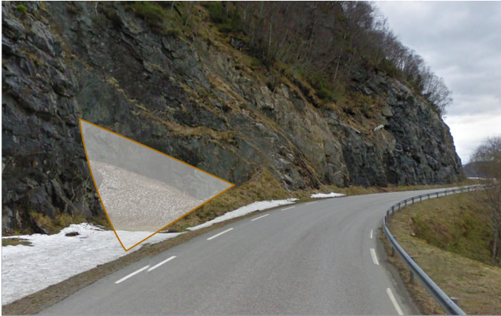
Figur 6: Volumberegning av lite skredmagasin. Foto: Google Street View
