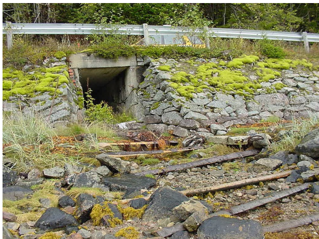
Figur 6: Stikkrenne. Foto: Per Gevik
