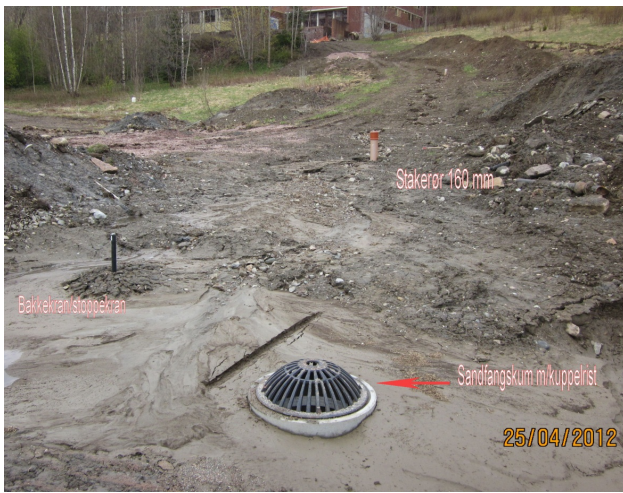
Sandfangskum, bakkekran og stakerør. Foto Terje Rønneberg
