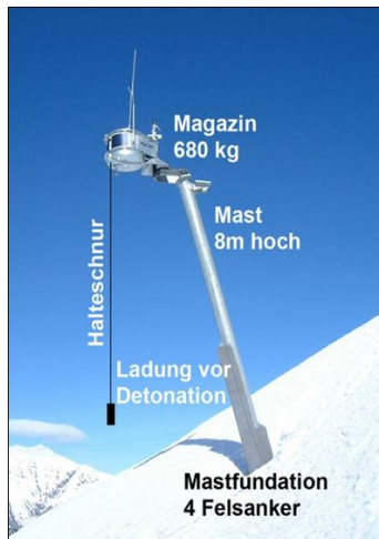
Figur 3: Skredutløsning med Wyssttåm. Foto: Wyssen avalanche control AG
