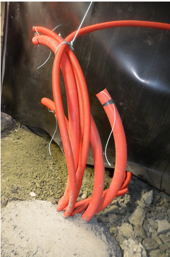
Trekkerør i bankett. Foto: Tore Paulsen
