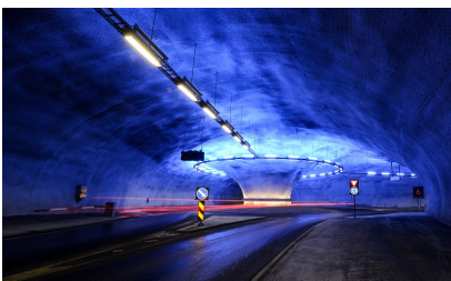
Lyssetting i Vallaviktunnelen. Foto Knut Opeide
