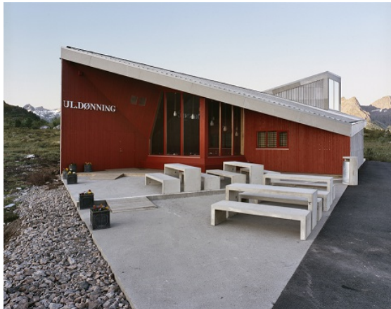
Figur 3: Eksempel på toalettanlegg i privat bygg
