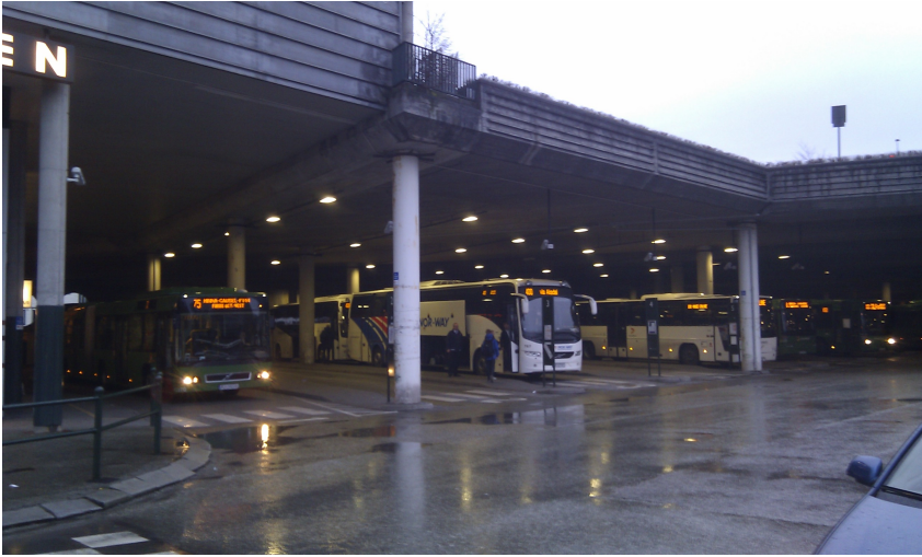
Figur 3: Repos/Venteareal på kollektivterminal
