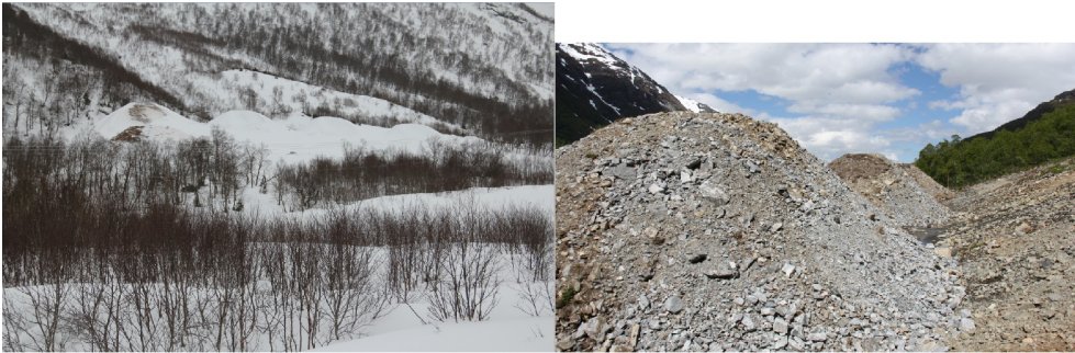
Figur 3: Eksempler på bremsekjegler. Foto Anne Marit Øksenvåg og Reidun Øverland
