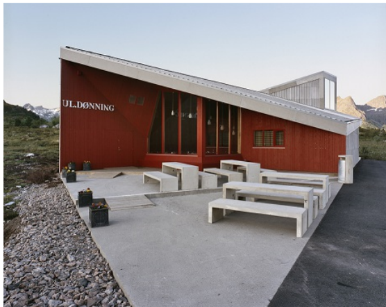
Figur 3: Eksempel på toalettanlegg i privat bygg
