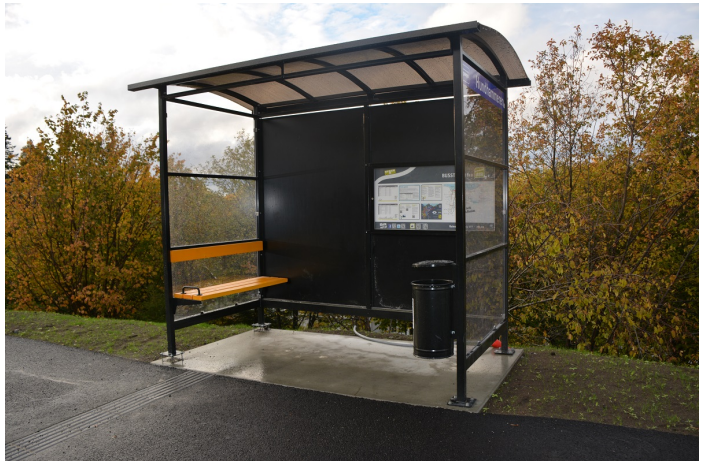
Avfallsdunk plassert i et leskur. Foto: Tore Paulsen
