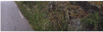
Fto Statens vegvesen
