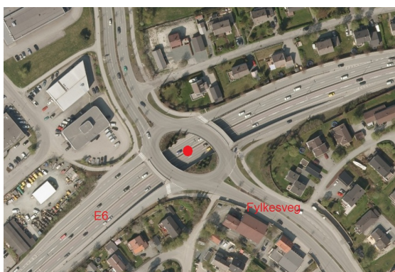
Nardokrysset på Omkjøringsvegen i Trondheim
