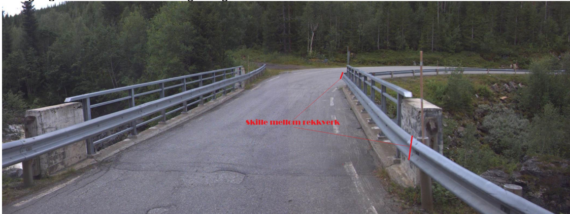
Rekkverk på/ved bru. Foto: Statens vegvesen
